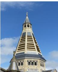
*Dieses Monstrum aus Stahlbeton wurde 1926 erbaut. Der Innenraum besitzt keinen einzigen Stützpfiler. Bemerkenswert das kleine Eckhaus aus Fachwerk genau gegenüber.*
